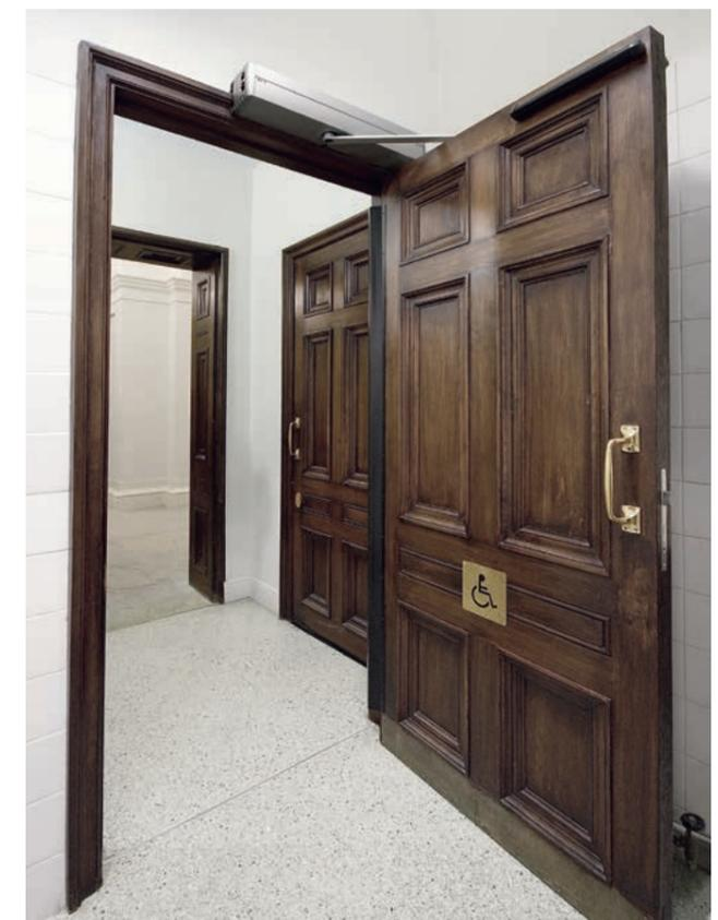
In der historischen St. George's Hall, Liverpool, sorgt der automatische Drehflügeltürantrieb ED 200 für einen barrierefreien WC-Zugang auf dem neusten Stand der Technik.
