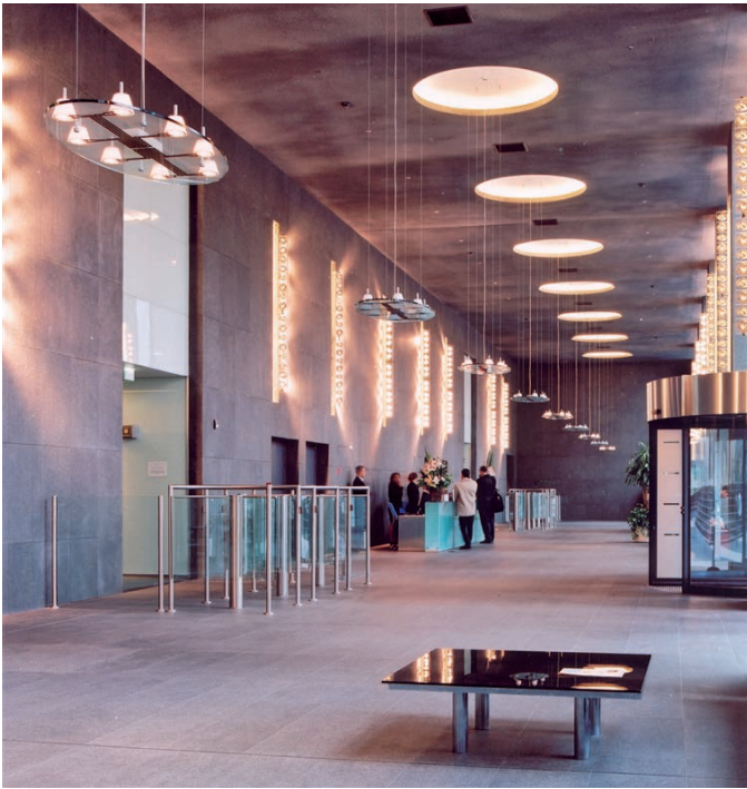
Mehrfachanlage im Foyer – in Sichtweite vom Empfangspersonal
