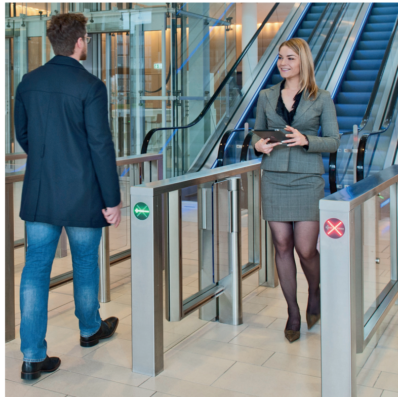
Signale grün/rot zeigen eindeutig, ob der Weg frei oder gesperrt ist
